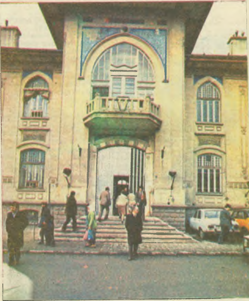
Maliye Bakanlığı: Kapıdan memurlara ne çıkacak?
